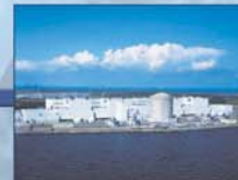
Darlington 4 unités 925 MWe In-service: 1980-83
