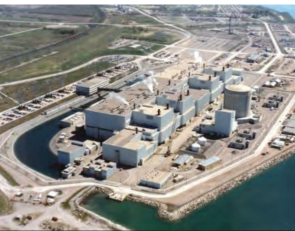
Centrale Darlington d'Ontario Power Generation à Clarington, en Ontario.
