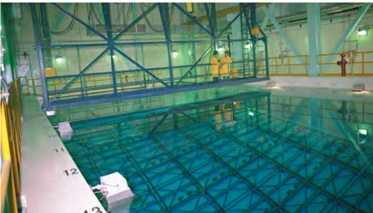
Dans chacune des centrales nucléaires canadiennes, le combustible irradié est immergé dans une piscine de stockage où il est constamment surveillé. L'eau favorise son refroidissement.
