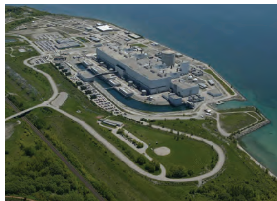
La centrale nucléaire Darlington, d'Ontario Power Generation, peut répondre aux besoins en électricité de la ville de Toronto sans émettre aucun des gaz en cause dans le réchauffement planétaire ou le smog.
